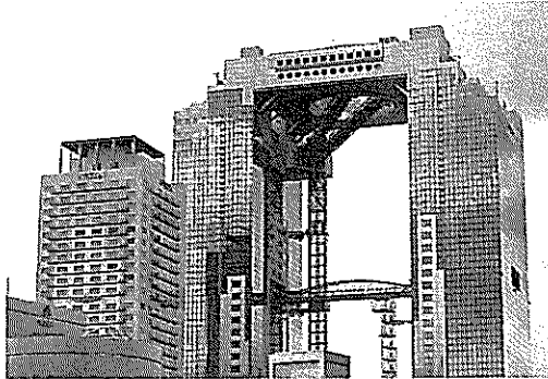
実験で空調システムを更新する新梅田シティ(大阪市北区)
